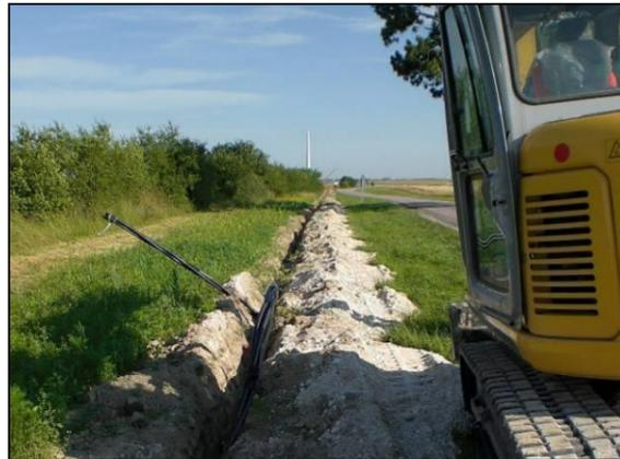
Photo 76 : Pose de câbles électriques et réalisation de tranchée à la pelle mécanique (Source : BE Jacquél et Chatillon)
