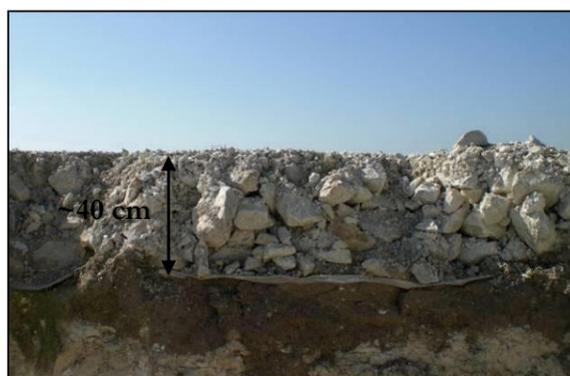
Photo 70 : Type de remblais utilisés pour le renforcement des chemins d'accès (Source : BE Jacquelin et Chatillon)
