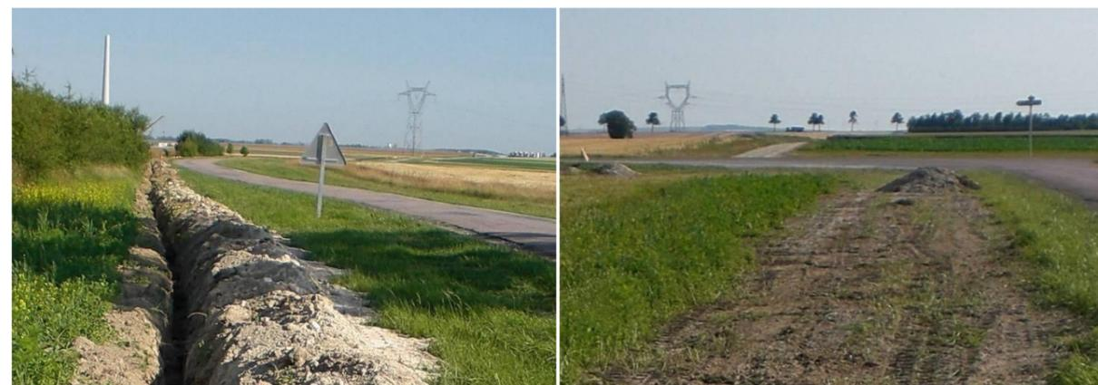
Photo 82 : Rebouchage de tranchée après passage des câbles électriques (Source : BE Jacquel et Chatillon)
