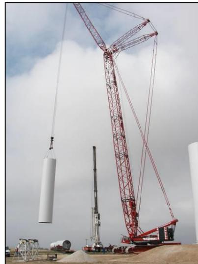
Photo 66 : Exemple d'assemblage d'un mât d'éolienne (Source : BE Jacquiel et Chatillon)
