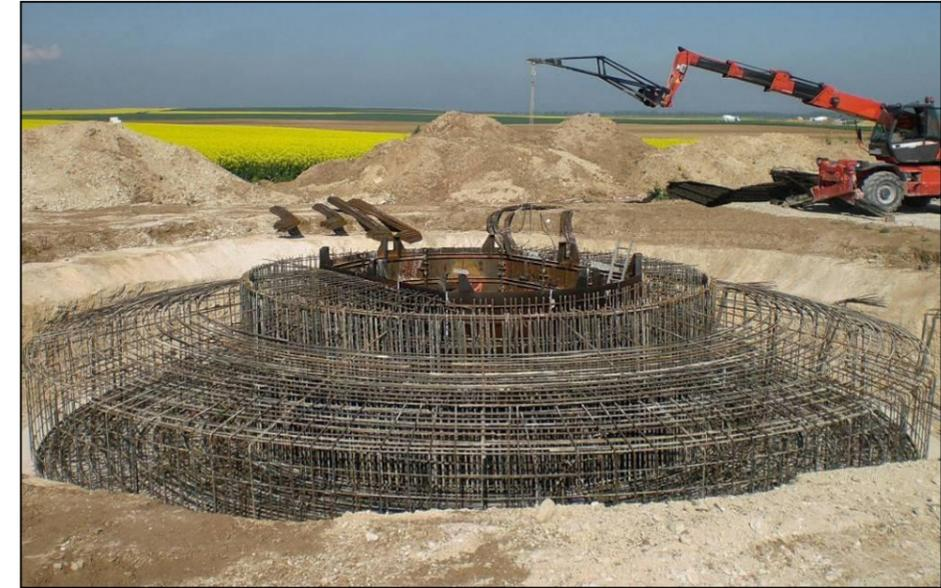
Photo 74 : Exemple de maillage d'acier d'armature pour fondation d'éoliennes de type massif poids (Source : BE Jacquel et Chatillon)
