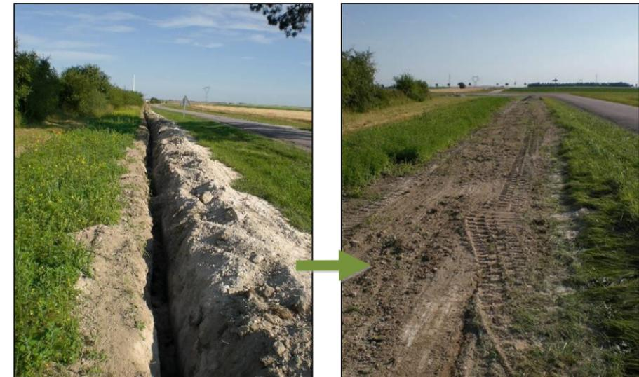
Photo 78 : Rebouchage de tranchée après passage des câbles électriques (Source : BE Jacquél et Chatillon)
