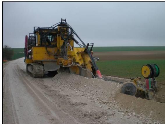
Photo 77 : Pose mécanisée de câbles électriques (Source : BE Jacquél et Chatillon)
