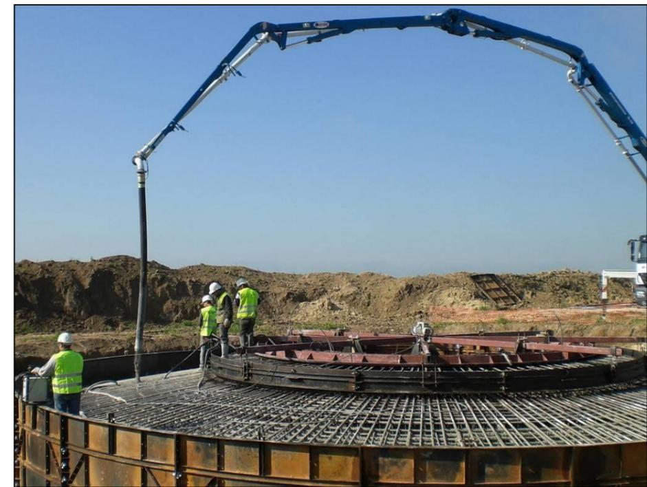
Photo 75 : Exemple de coulage du béton de fondation d'éolienne (Source : BE Jacquel et Chatillon)
